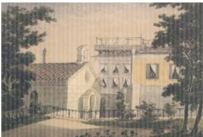
8. Een blik op het terrein van de Nederlandse ambassade in Constantinopel, circa 1850. Op de voorgrond de zogenaamde ‘Dutch Chapel’, daarachter de opgelapte ambassade.
