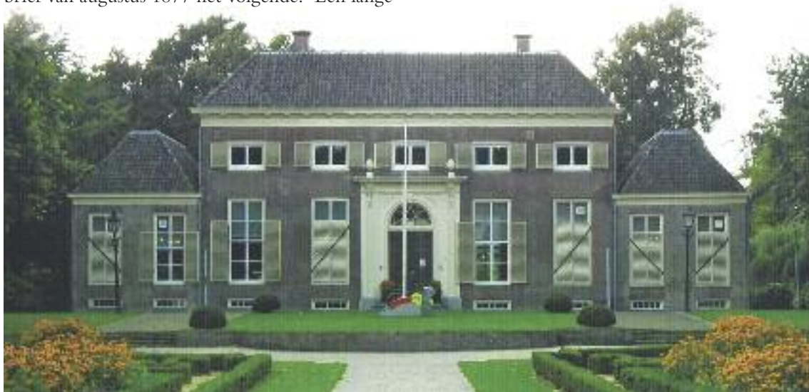
13. Het Heerenhuys in Het Park, de voormalige woning van J.A. Nottebohm. Foto Albert Brussee, september 2013.
